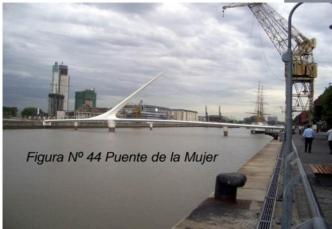
El puente peatonal conforma una tipología de "puente atirantado".
