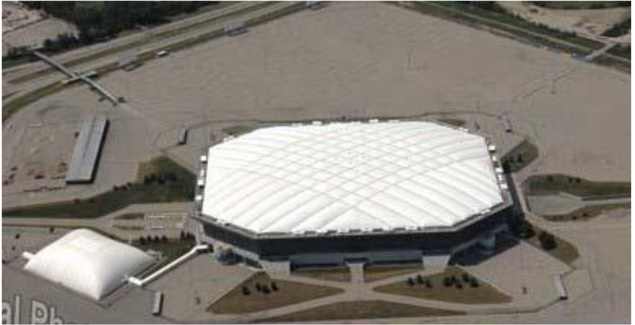
Figura Nº 1. El Pontiac Silverdome, Detroit, Michigan, EEUU (1975)- 80.325 espectadores. Una de las estructuras más grandes soportadas por aire.
