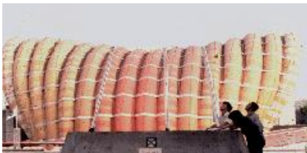
Figura Nº 8. Pabellón FUJI en la Expo Osaka 1970. Se utilizaron en su construcción 16 tubos cerrados de 3,60 metros de diámetro cada uno. La altura total de la estructura fue de unos 23 metros y su forma intentaba asemejar la cubierta de una carreta del viejo oeste norteamericano.
