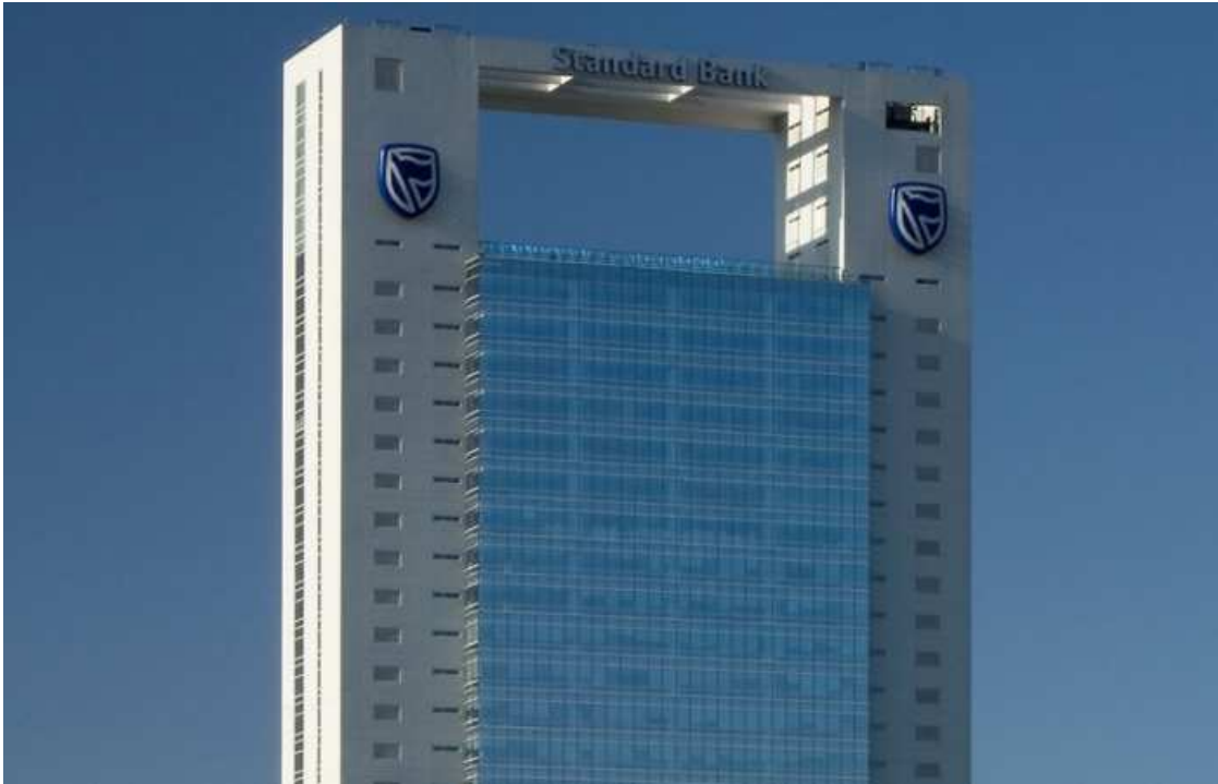
Vista del sector superior del edificio “Madero Office”
