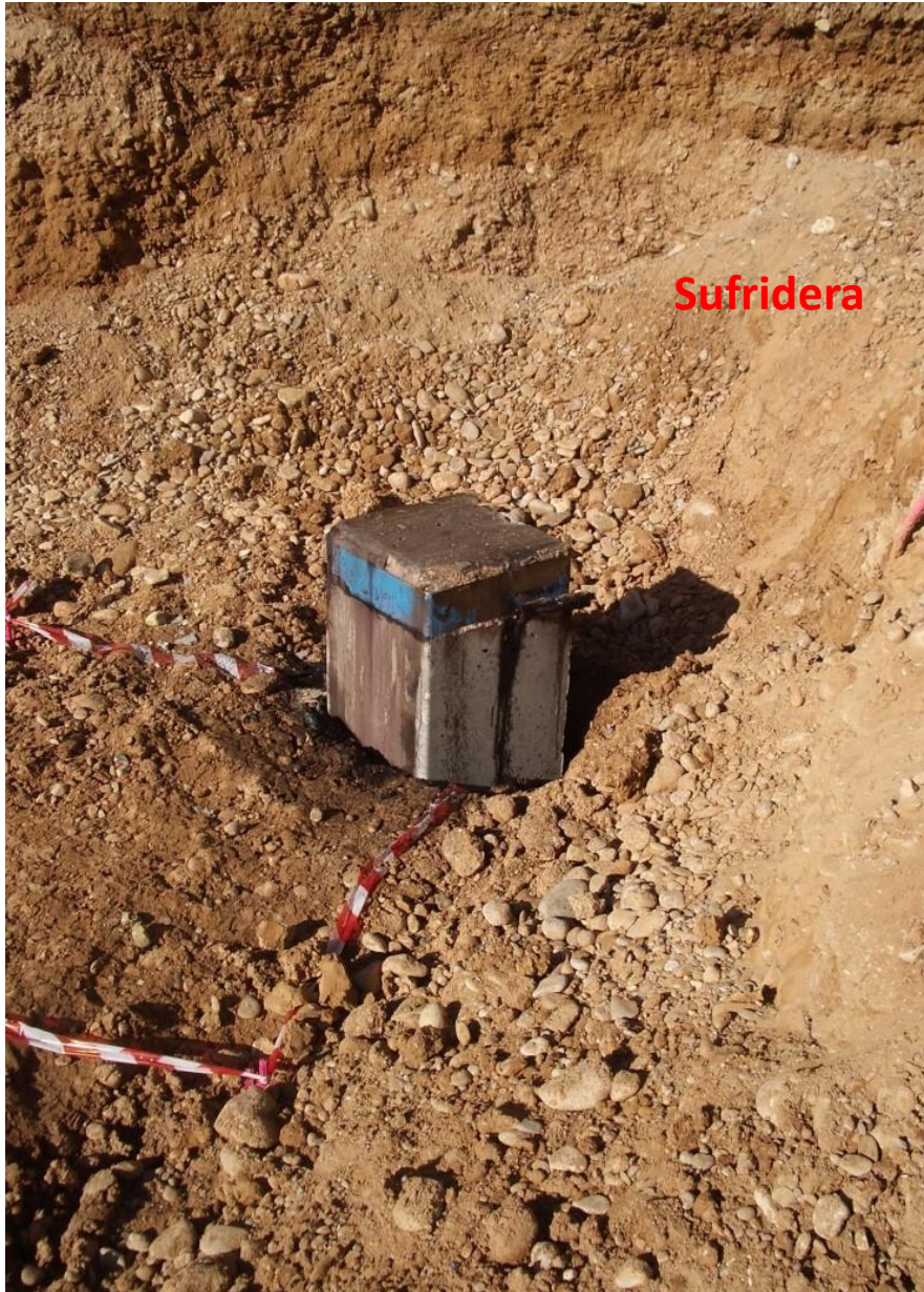
Placa de unión entre pilotes
