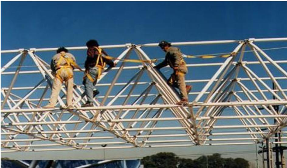
Figura Nº 3 Ajuste en la construcción de una grilla plana
