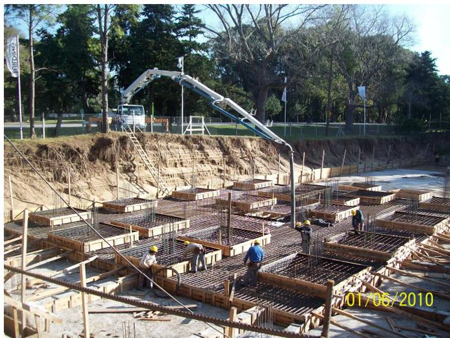
Las plateas nervuradas (fig. d y e) no son otra cosa que una losa nervurada con una serie de nervios principales bajo las líneas de columnas y otros secundarios. Los nervios se pueden hacer por arriba o por debajo de la losa.
