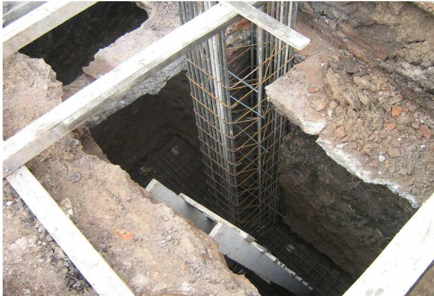
**Columna de una base excéntrica (notar la orientación del tronco y densificación de armadura paralela a la medianera para absorber el momento flector)**
