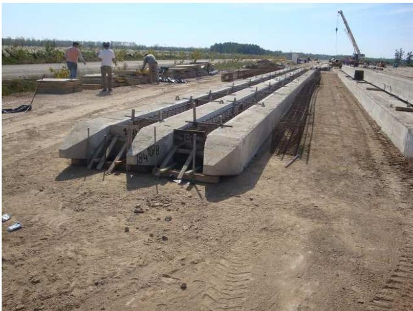
Se arman como una columna, con armaduras longitudinales y estribos cerrados o preferentemente con un zuncho cuyo paso se disminuye en la cabeza y en la punta para absorber los efectos del hincado. Durante el hincado los golpes se aplican en la cabeza mediante un elemento compuesto por acero y madera denominado sufridera. La punta se protege con un azuque metálico.
