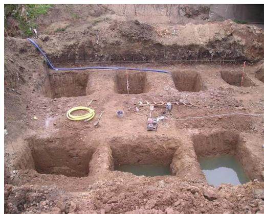
Imagen 1 y 2: Base aislada termianda y Excavaciones para una bateria de bases
