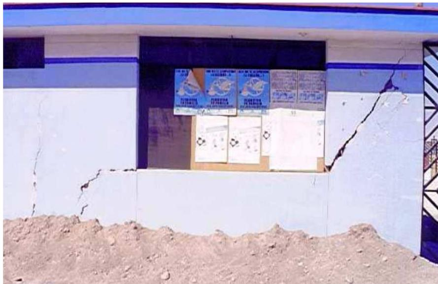
**Figura 17: EFECTO DE UN SUELO EXPANSIVO**
