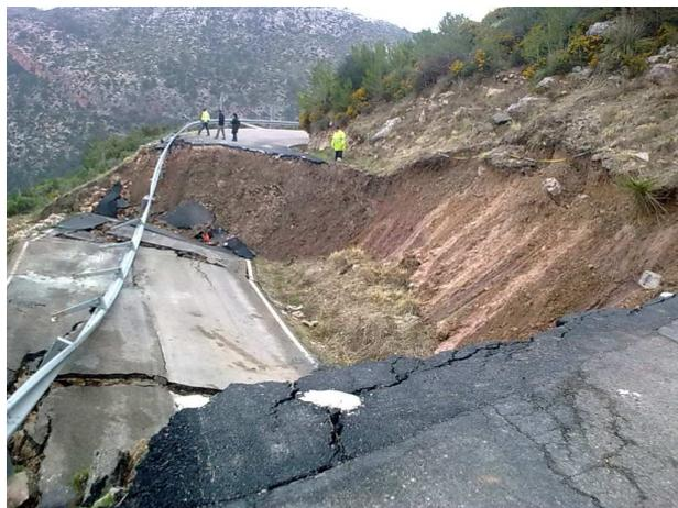
Figura 22: CUÑA DE ROTURA DE UN SUELO
