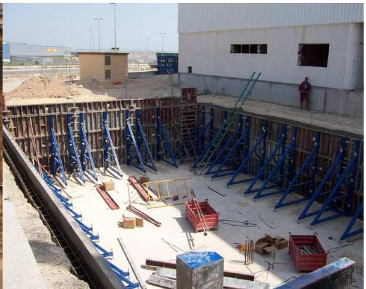
**Figura 2 Muro de contención de una excavación**
