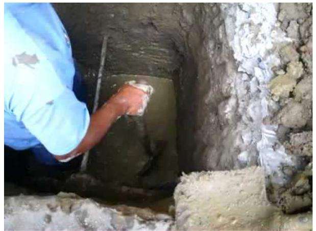
**Figura 15: Napa freática en una excavación**
