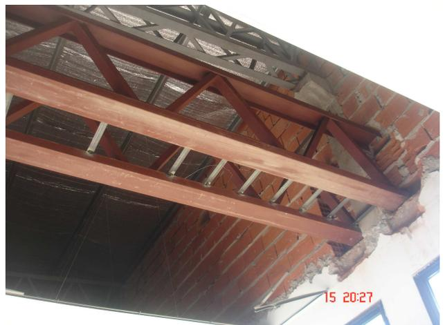
Los perfiles L de alas iguales o los T, son de menor tamaño que los anteriores y, estructuralmente hablando, se los utiliza formando parte de un conjunto ya sea como viga o columna reticulada
