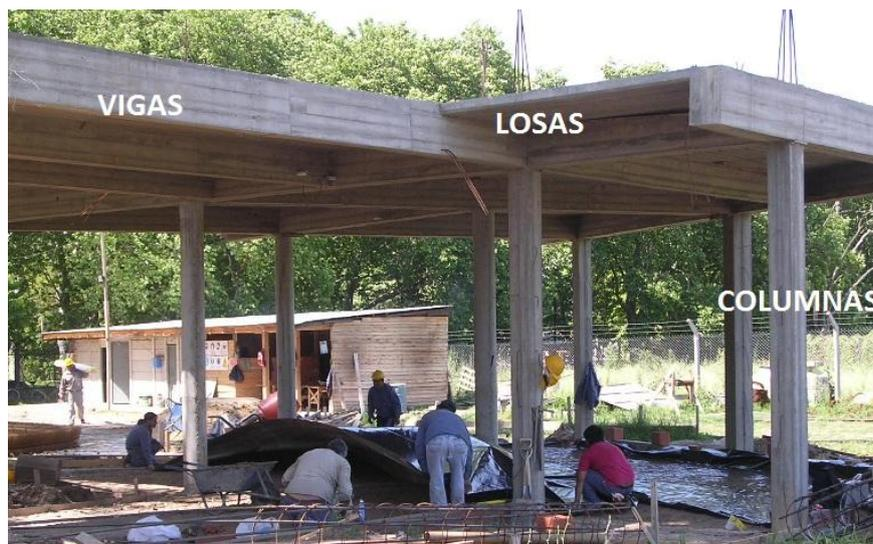
Se define **losas** a los elementos planos, en los que dos de sus dimensiones predominan sobre la tercera, (el espesor), cargados perpendicularmente a su plano
